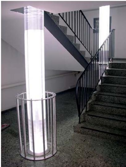
Ein dem Stand der Sonne nachgeführtes Spiegel-Linsensystem mit 100.000 lm Lichtstrom
